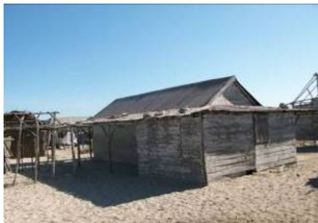
Figure 8 Maison construit en a) chaux b) vondro c) bois
